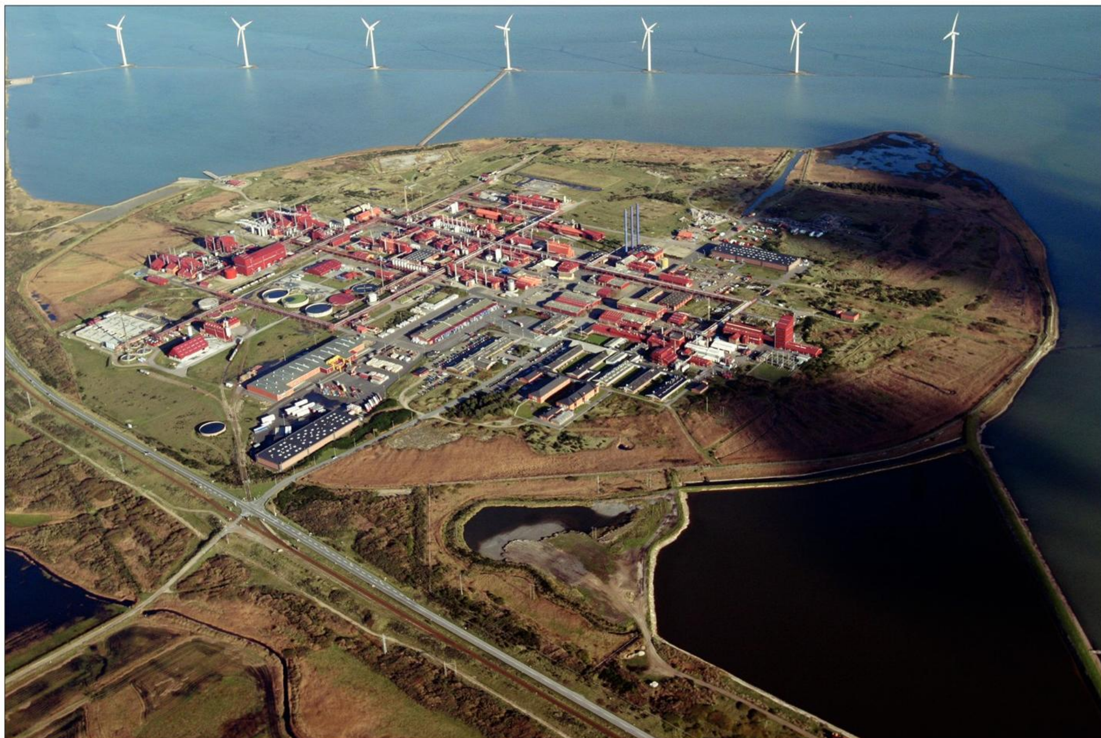
Luffoto af Cheminovas produktionsanlæg på Rønland. Det biologiske rensningsanlæg ligger i det sydvestlige hjørne af fabriksarealet og ses nederst til venstre. Fotograf: Benny Vejlbj
